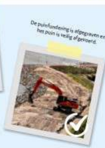
Voorbereidend werk voor het vogeluitkijkpunt op de Buldijk.
